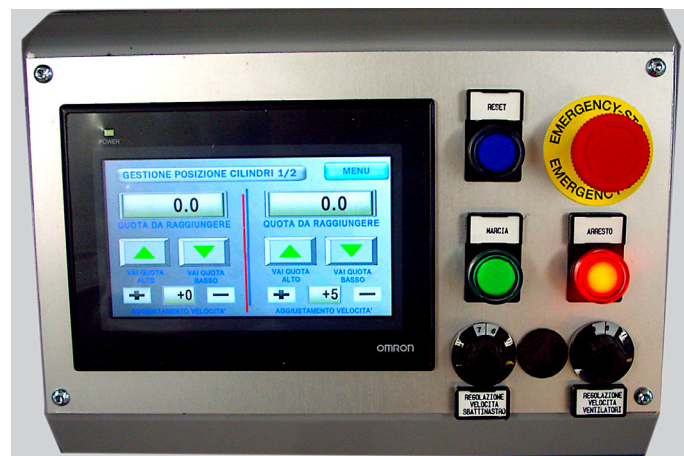
PANNELLO DI CONTROLLO CONTROL PANEL
